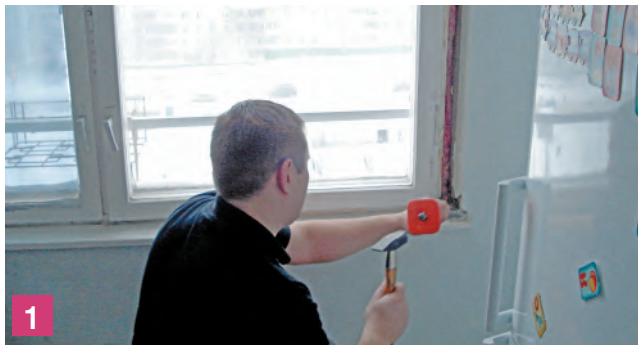
Демонтаж отливов и подоконников
