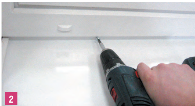
Установка отливов
