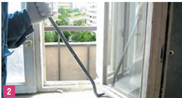
Освобождение старой оконной рамы
